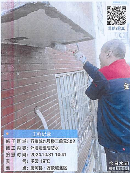
工程记录 施工区域: 万象城九号楼二单元302 施工内容: 外墙刷透明防水 拍摄时间: 2024.10.31 10:45 天气: 多云 19°C 地点: 唐河县·万象城北区
