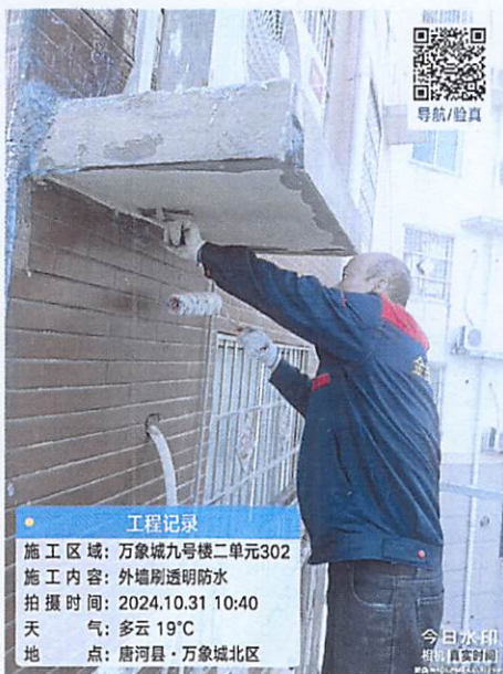
工程记录 施工区域: 万象城九号楼二单元302 施工内容: 外墙刷透明防水 拍摄时间: 2024.10.31 10:45 天气: 多云 19°C 地点: 唐河县·万象城北区
