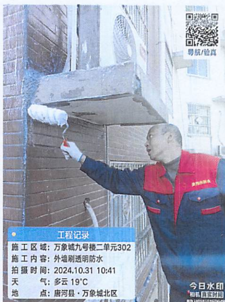
工程记录 施工区域: 万象城九号楼二单元302 施工内容: 外墙刷透明防水 拍摄时间: 2024.10.31 10:40 天气: 多云 19°C 地点: 唐河县·万象城北区
