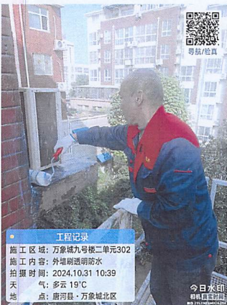
工程记录 施工区域: 万象城九号楼二单元302 施工内容: 外墙刷透明防水 拍摄时间: 2024.10.31 10:41 天气: 多云 19°C 地点: 唐河县·万象城北区
