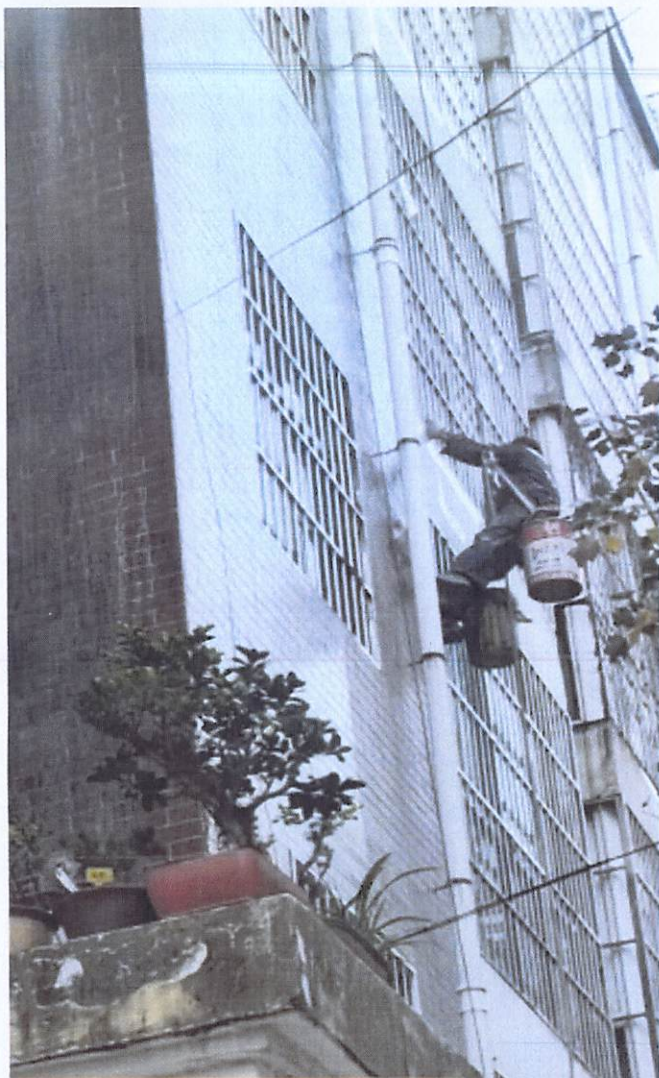
工作记录 工作内容: 房管人员维修万象城7#3 单元外墙维修中 拍摄时间: 2024.11.12 08:58 地点: 唐河县·万象城 经度: 112.844111°E 纬度: 32.674829°N
