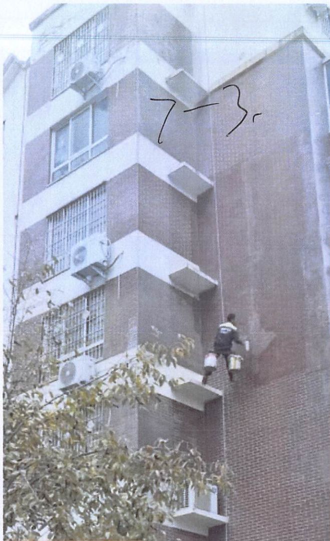
工作记录 房管人员维修万象城7#3 单元外墙维修中 24.11.12 15:54 唐河县·万象城 112.844210°E 32.674742°N
