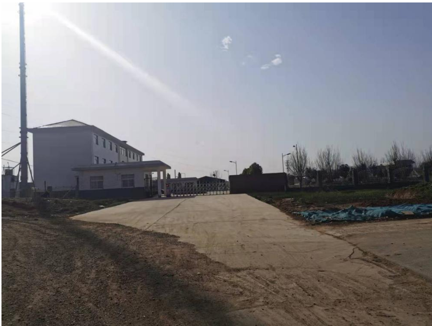
唐河县河西污水处理厂
